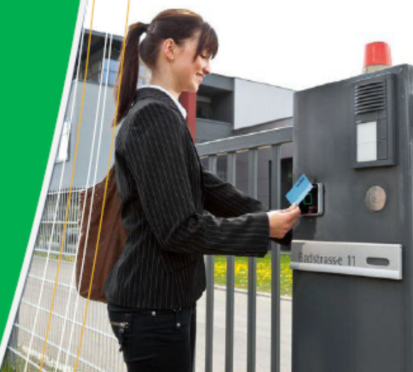
Zutrittsprozedur mit einem RFID-Ausweis
